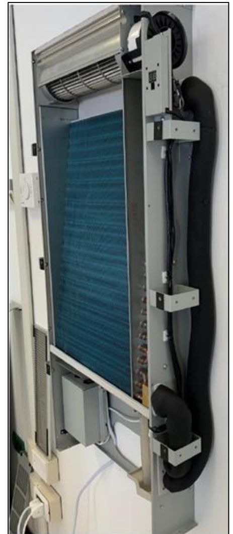
Szigetelje a csöveket a képen látható módon
