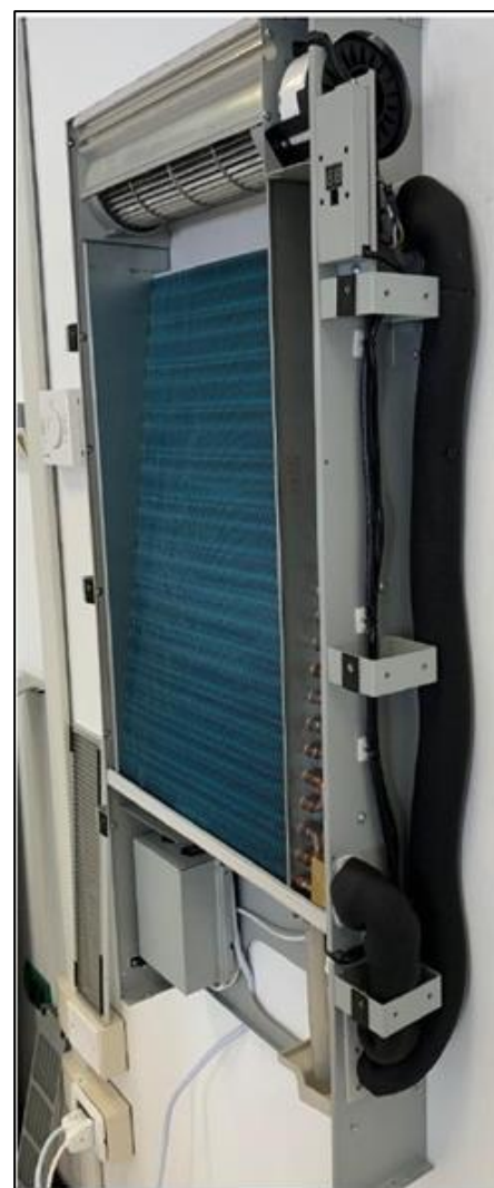
Szigetelje a csöveget a képen látható módon
